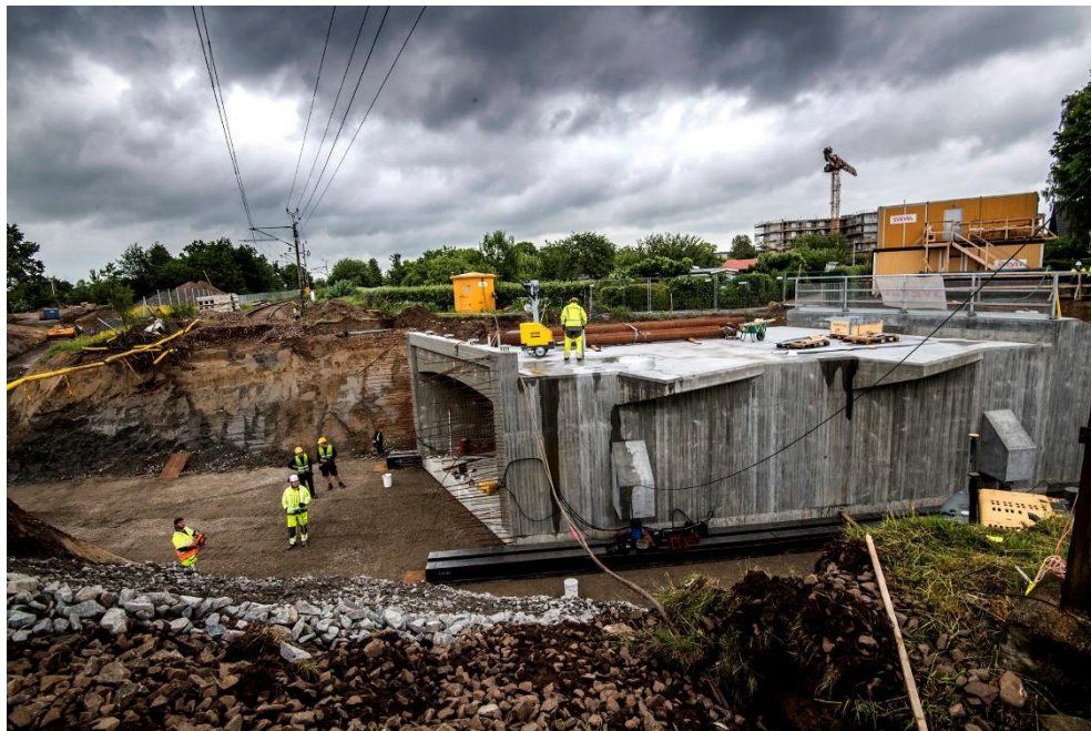
Figur 3, Exempel av lansering in under banvall
